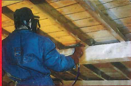
Pulvérisation du gel à la pompe haute pression
