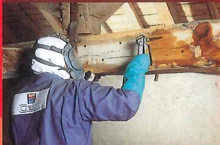
Injection en profondeur
