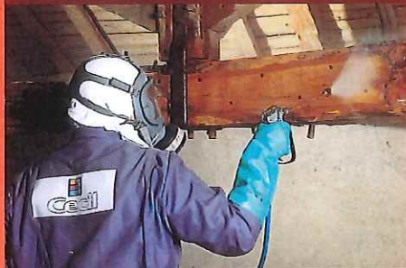
Application de surface par pulvérisation
